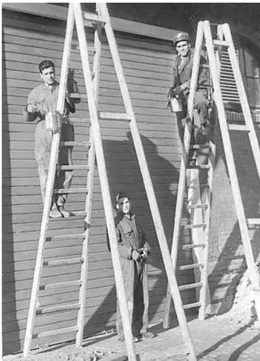
1953 - Caracas (Venezuela) Antonio Murro (sulla scala a sinistra) con altri operai al lavoro.
